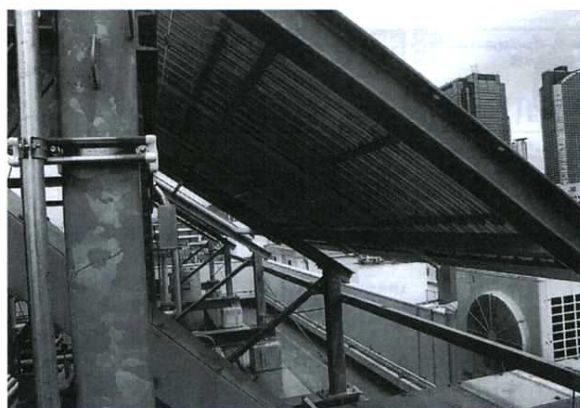
西側に2段重ねで8枚からなるドイツ・パラデグマ製反射板付き集熱器
