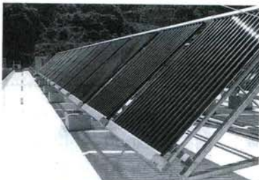
16枚で1集熱回路を構成する太陽集熱器群。
